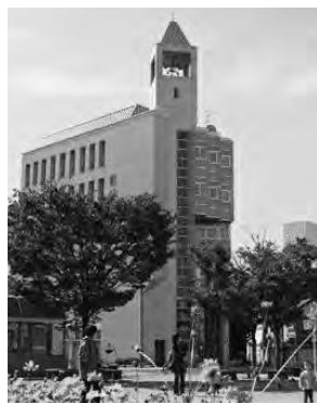
豊橋市民センター(カリオンビル)の外観
