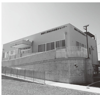
完成した津波防災センター(三郷地区)
