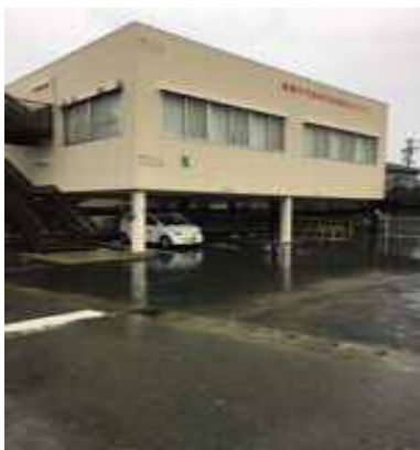
天津地区津波防災センター
