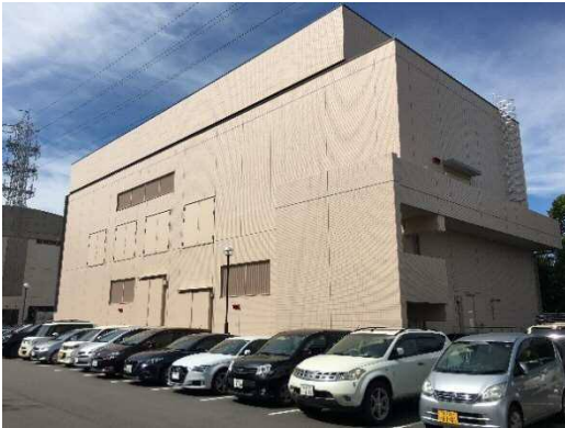
特別高圧変電所の外観
