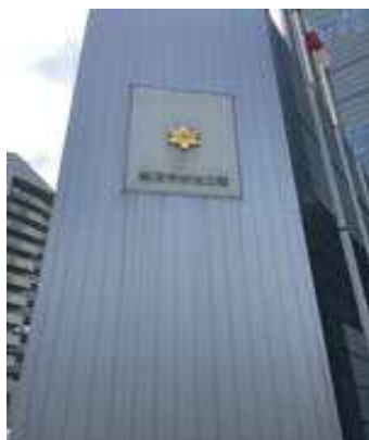
中消防署 外観
