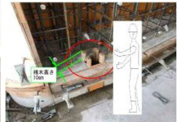
角落し箱抜き型枠据付前 (写真は発生場所と同様の構造部分)
