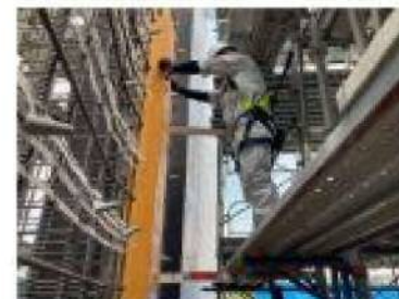
角落し箱抜き型枠据付前 (写真は発生場所と同様の構造部分)
