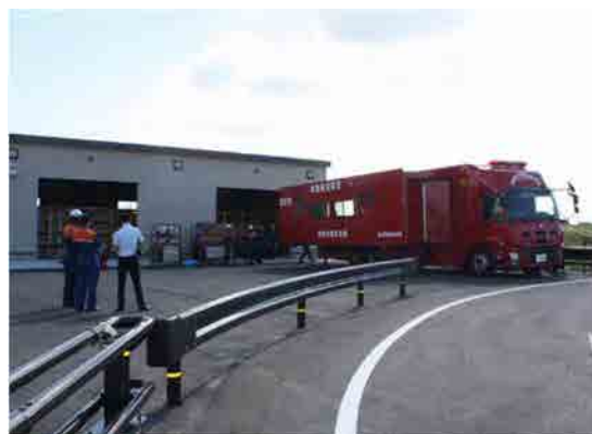
道の駅「とよはし」の防災備蓄倉庫
