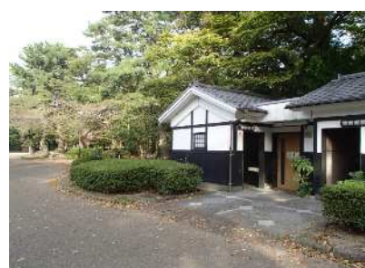
写真 リニューアルしたトイレの例 (豊橋公園) (施策3-1に関連)
