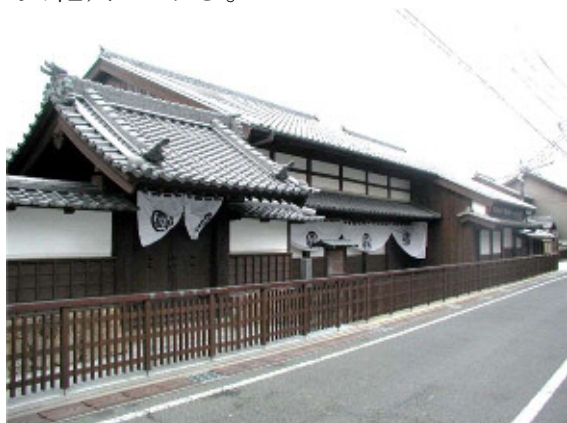
【二川宿本陣の外観】
