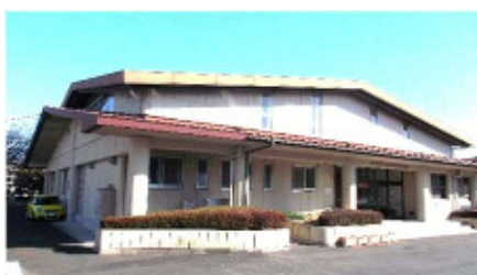
【二川地区体育館】
