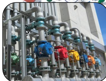
建築設備工事
