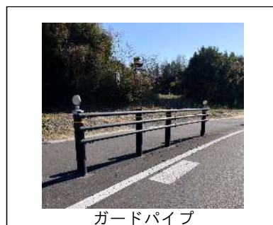
ガードパイプ
