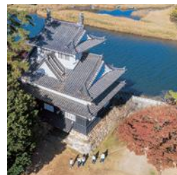
ドローン写真 #集合写真ポツ案 #試し撮り失敗
