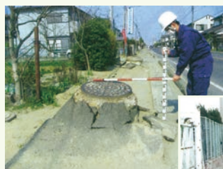
マンホールの浮き上がり (平成23年(2011年)東北地方太平洋沖地震)
