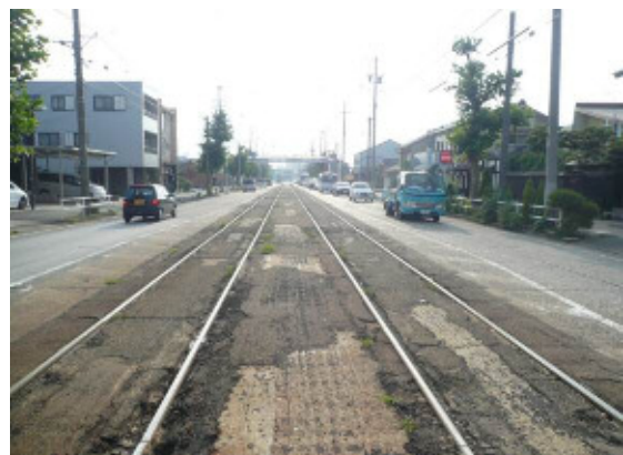
損傷が進む軌道敷（東八町～前畑電停間）
