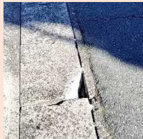
側溝の破損
