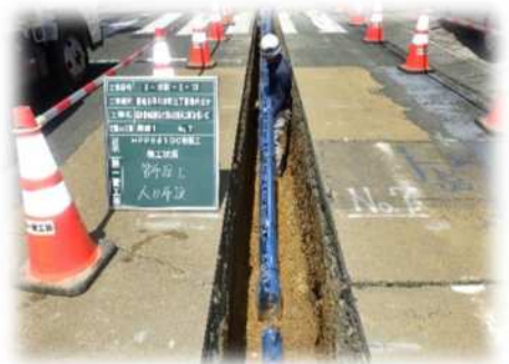
水道管耐震化工事の様子
