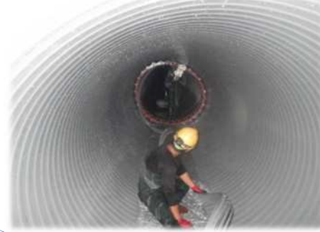
下水道管更生工事の様子
