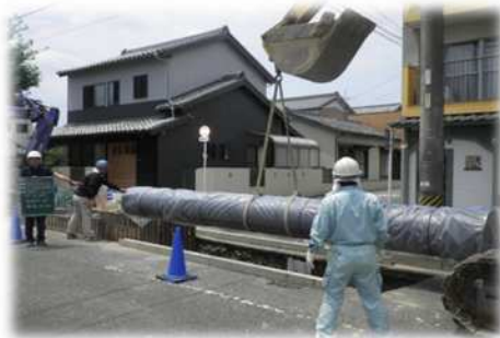
水道管耐震化工事の様子
